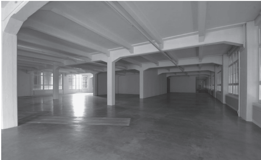
Kammgarn Westflügel, Innenansicht 3. Obergeschoss (Quelle: Baugeschichtliches Detailinventar Vestigia)
