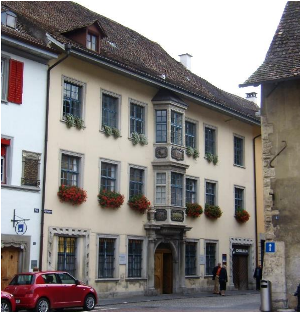
Abbildung 2: Aussenansicht der Liegenschaft «Freudenfels»
