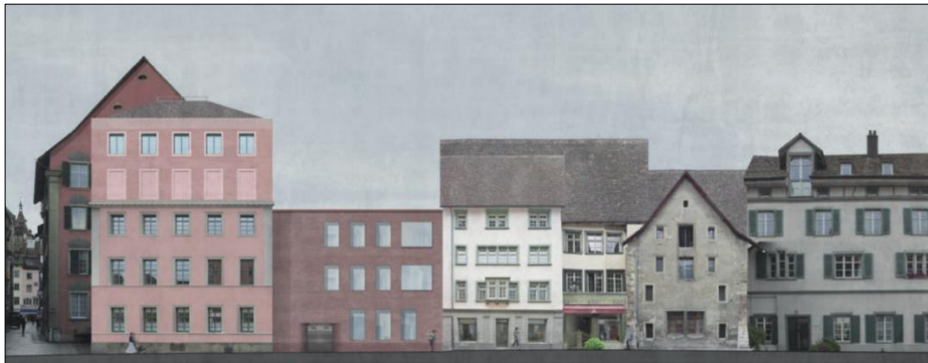
Abbildung 10: Fassade aus der Safrangasse mit aufgestocktem «Eckstein» (links) und dreistöckiger Verwaltungsneubau (zweites Gebäude von links)
