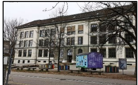
Dachausbau Schulhaus Emmersberg
