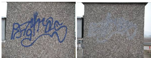
Vorher - nachher: DB Trafo-Station in Beringen
