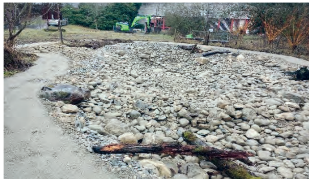
Schulhaus Gräfler Teich West, ökologisch gestalteter Teichgrund
