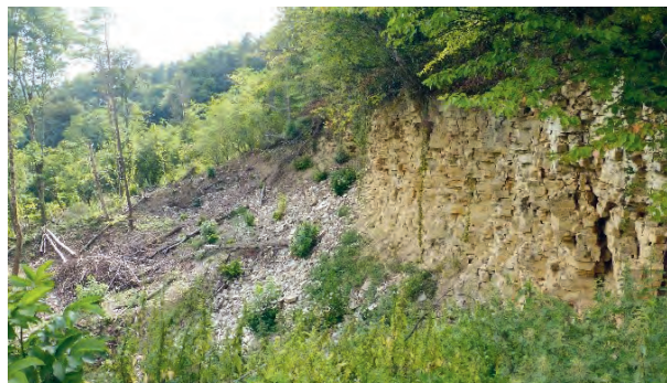
Gehrenhalde, freigelegte Felswand
