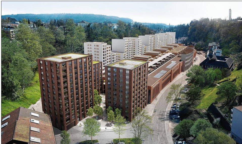
Abbildung 1: Die entwickelte Stahlgießerei im vorderen Mühlental
