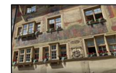
Sanierung Verwaltungsliegenschaft Käfig
