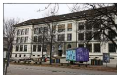
Dachausbau Schulhaus Emmersberg
