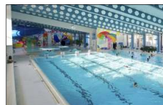
Neubau KSS Hallenbad
