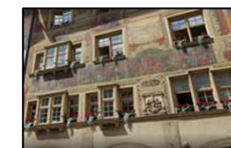
Sanierung Verwaltungsliegenschaft Käfig
