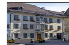
Sanierung Liegenschaft Freudenfels
