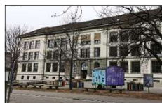
Dachausbau Schulhaus Emmersberg
