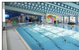
Neubau KSS Hallenbad
