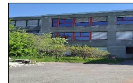
Sanierung Schulhaus Gräfler
