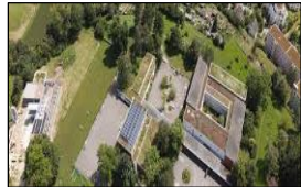
Sanierung & Erweiterung Schulzentrum Alpenblick
