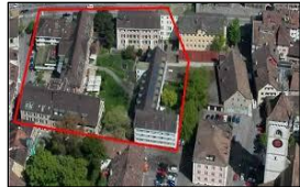
Sanierung Alterszentrum Kirchhofplatz
