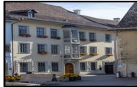
Sanierung Liegenschaft Freudenfels
