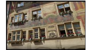
Sanierung Verwaltungsliegenschaft Käfig
