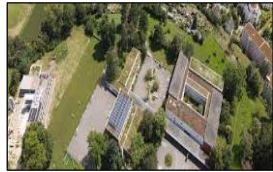
Sanierung & Erweiterung Schulzentrum Alpenblick
