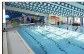
Neubau KSS Hallenbad
