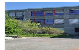
Sanierung Schulhaus Gräfler
