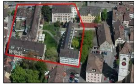
Sanierung Alterszentrum Kirchhofplatz
