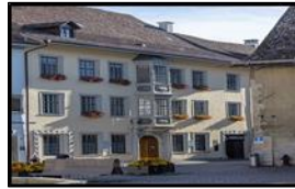
Sanierung Liegen- schaft Freudenfels
