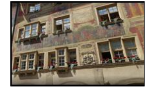
Sanierung Verwaltungs- liegenschaft Käfig
