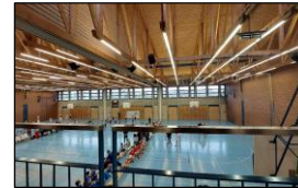
Sanierung Dreifachturnhalle Breite
